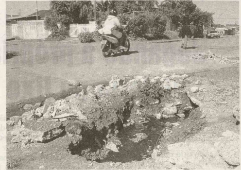
Canos estourados e esgoto a céu aberto podem ser vistos mesmo na calçada, devido ao tráfego das carretas
