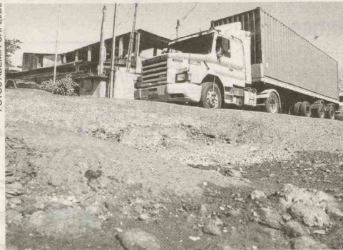
Com os buracos causados pelo tráfego intenso de caminhões, outros veículos menores, para desviar, realizam manobras arriscadas
